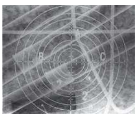
【X線探査によるコンクリート内部画像】
